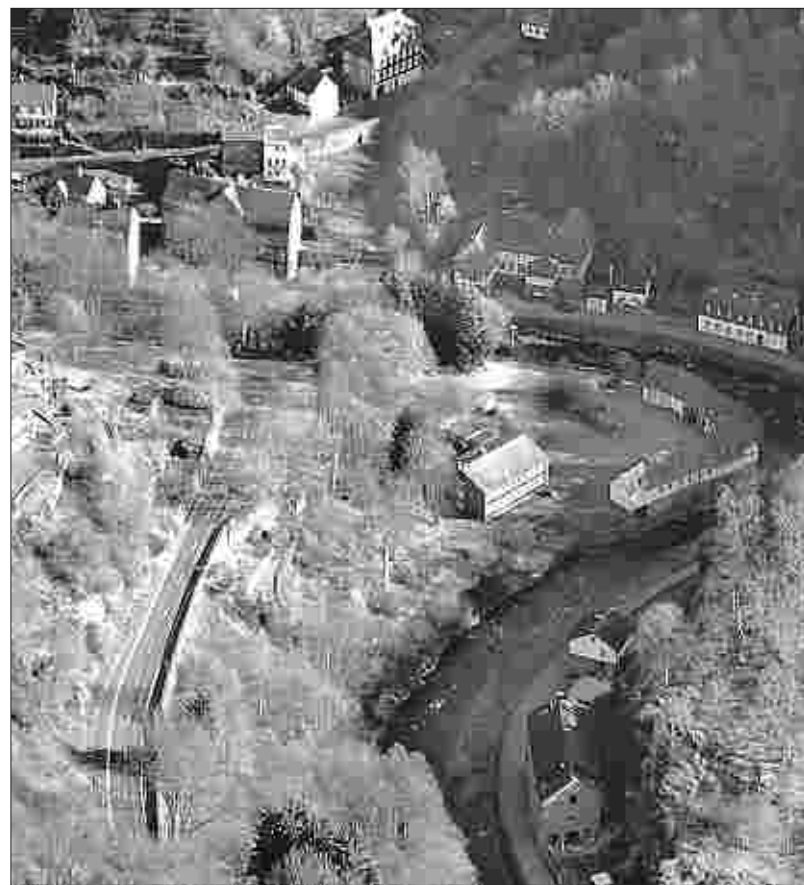
Der Hotelkomplex im Monschauer Rosenthal kommt – davon ist Bürgermeister Theo Steinröx mehr denn je überzeugt. Die RWE-Gebäude (Bildmitte) werden dafür abgerissen. Foto: Heiner Schepp
